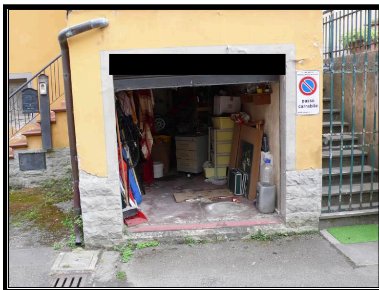
Foto 7-8-9: Soggiorno, servizio igienico piano secondo, ripostiglio piano terra.
